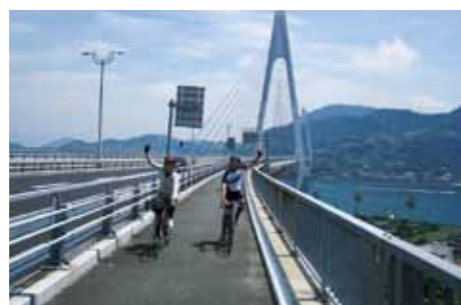
▲スレンダーな姿の因島と生口島を結ぶ生口橋
